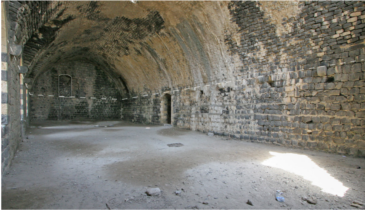
▲ Fig. 22 : Margat - Qal'at al Marqab. Vue du réfectoire, prise depuis le sud (cl. Maxime Goepf 2006). Est figuré en traits pointillés blancs le niveau de l'ancien plancher séparant les deux niveaux du réfectoire.
