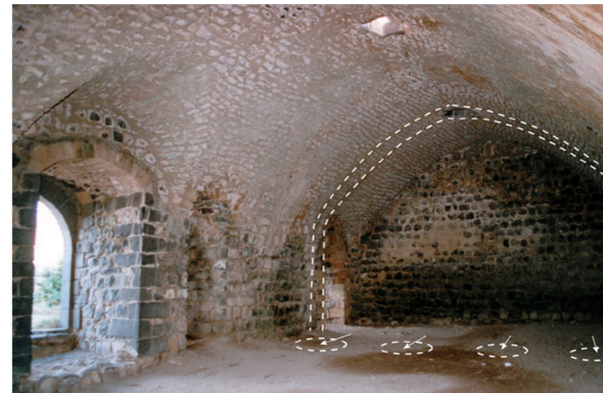
◀ Fig. 21 : Margat - Qal'at al Marqab. Vue de la salle de la cuisine, prise depuis le pignon ouest, avec superposition des structures retrouvées lors des fouilles (cl. JM 1994).
