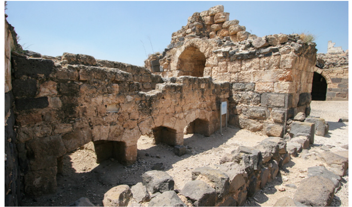
▲ Fig. 14 : Belvoir. Vue la salle de chauffe, prise depuis le nord-est (cl. Maxime Goepf 2005). À droite, substructions du mur fermant la salle de chauffe.
