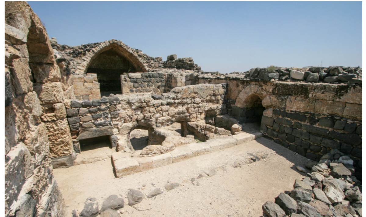
▼ Fig. 15 : Belvoir. Vue de la cuisine, prise depuis le sud-ouest (cl. Maxime Goepf 2005). De gauche à droite, l'ancienne cheminée bouchée et les trois fourneaux, du côté de la cuisine.
