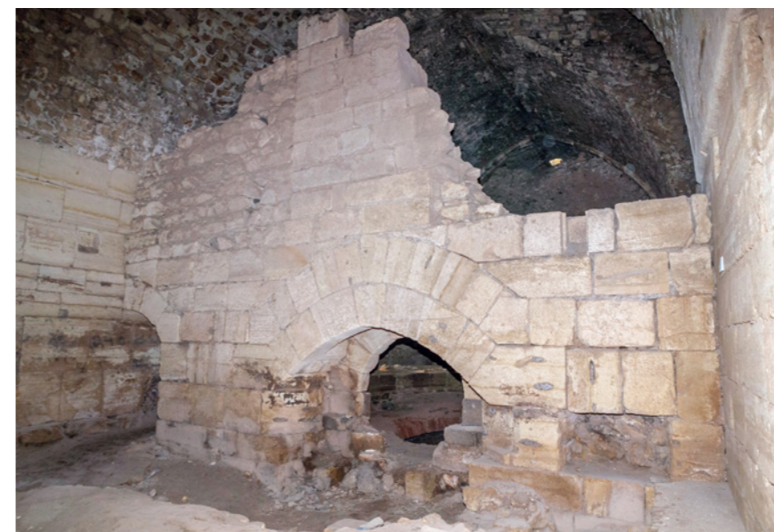
◀ Fig. 33 : le Crac des Chevaliers – Qal'at al-Husn. Vue du mur méridional du four, avec la bouche de la chambre supérieure, et la cheminée qui la domine (cl. Yves Ubelmann 2017).
