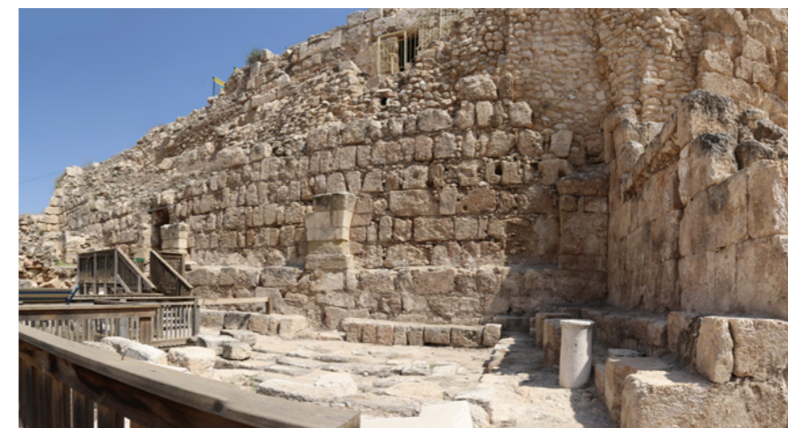
◀ Fig. 12 : Bethgibelin - Beit Guvrin. Le réfectoire, vu depuis le nord vers le sud-est. À droite, le mur pignon, avec l'estrade d'honneur, et les fûts qui portaient la table du châtelain. Au long du mur sud s'alignent les bancs de pierre destinés aux frères. On voit au fond à gauche la porte menant à l'église, ajoutée dans la deuxième phase (cl. JM 2019).
