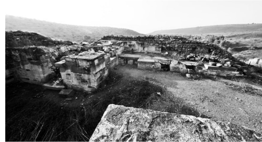
◀ Fig. 36 : le Chastellet du Gué de Jacob-Vadum Jacob-Ateret. Vue du complexe de la boulangerie pris depuis le nord (cl. Maxime Goepp 2018). Sur la gauche, le four, avec à l'extrême gauche la bouche de la chambre inférieure en grande partie défoncée ; on devine plus à droite la bouche de la chambre supérieure. À droite, les tables en basalte.
