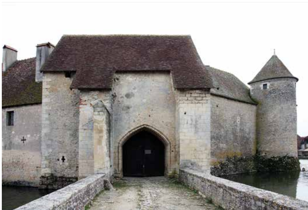
Fig. 6 – Sagonne, château, tour-porte, vue depuis l'ouest, 2016. À droite, la tour 1.
