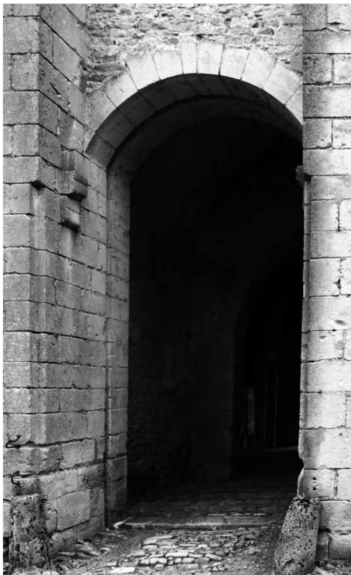
Fig. 15 – Sagonne, château, vue de l'arc bandé entre les contreforts de la tour-porche, traversé par la rainure de la herse, 2016. Noter sur le nu du parement les deux feuillures pour l'encastrement du pont-levis, et les consoles ménagées en hauteur pour accueillir l'axe des flèches et du contrepoids.
