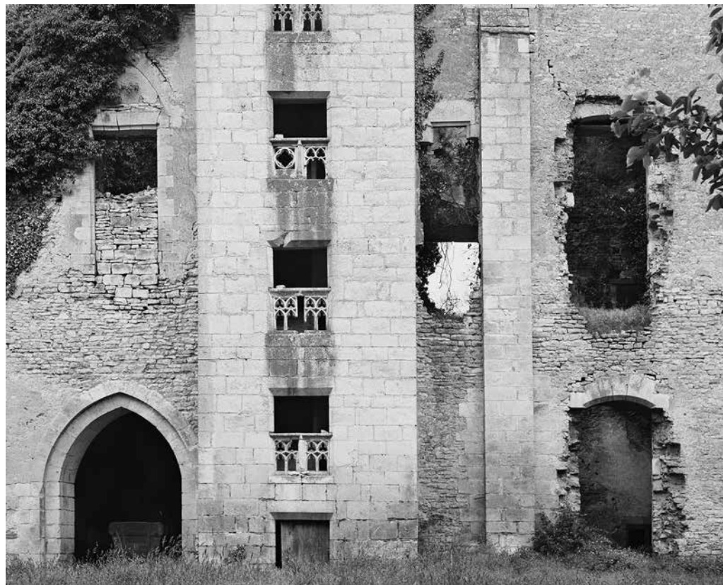
Fig.18 – Sagonne, château, ouvertures au rez-de-chaussée et au premier étage du « donjon », face orientale, vue prise en 1979 par Daniel Bontemps (MAP, cl. MH 296091, extrait).
