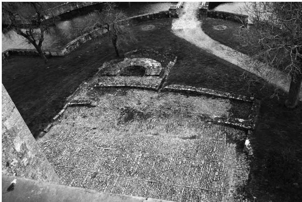
Fig. 5 – Sagonne, château, vue de dessus, depuis l'ouest, de la base de la tour de la Trésorerie, et fondations de la galerie qui s'appuyait à son revers, dans leur état actuel. Le pavage de la cour date probablement de l'époque de Mansart.
