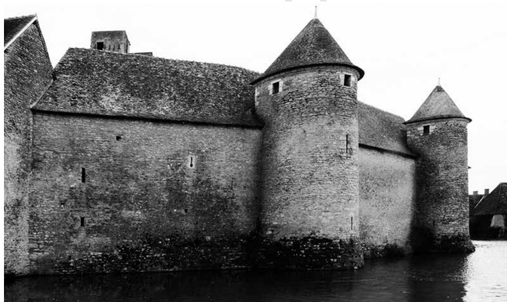
Fig. 8 – Sagonne, château, tours 1 et 2 depuis le sud-ouest, 2016. Noter les embrasures pour armes à feu d'époques diverses pratiquées dans la courtine et dans le flanc des tours.
