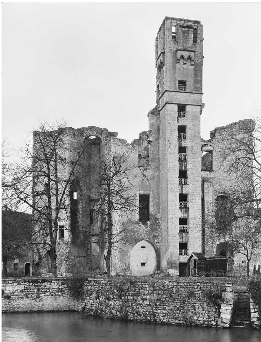
Fig. 14 – Sagonne, château, ensemble résidentiel, vue prise depuis le sud-est par Lucien Roy (vers 1930?), faisant apparaître les éventrations de la grosse tour (MAP, cl. 10I06750).
