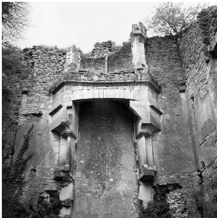
Fig. 20 – Sagonne, château, cheminées du deuxième et du troisième étage du pignon nord avant restaurations, vue prise en 1979 par Daniel Bontemps (MAP, cl. MH 296106).
