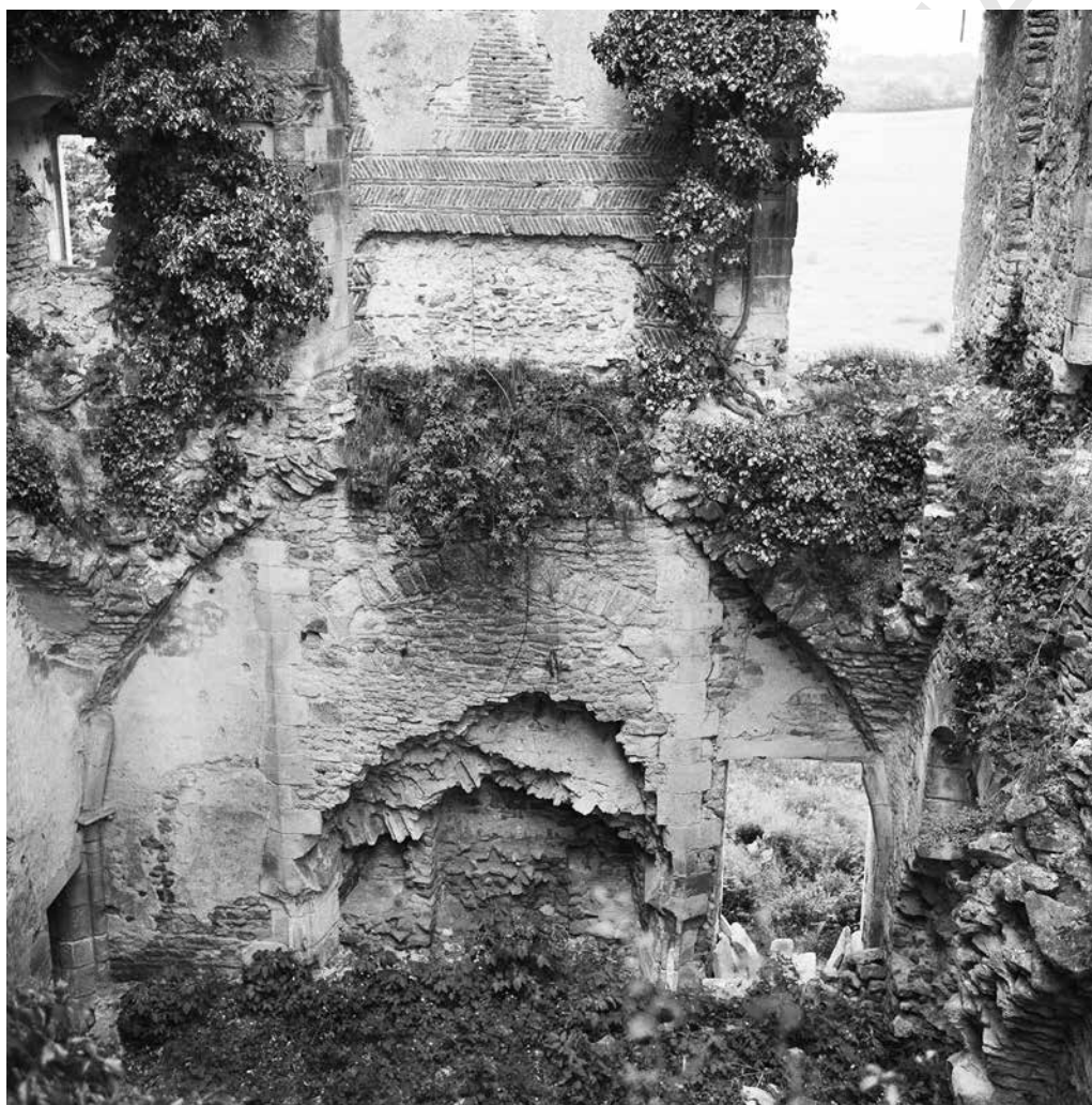
Fig. 17 – Sagonne, château, travée nord de la salle du rez-de-chaussée et contrecœur de la cheminée de la grande salle, vue prise en 1979 avant restauration par Daniel Bontemps (MAP, cl. MH 296108).
