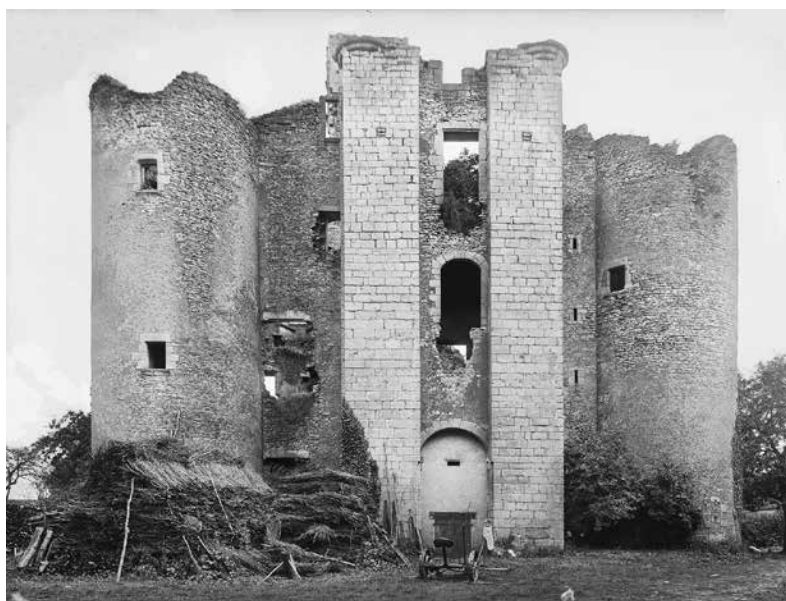
Fig. 10 – Sagonne, château, façade ouest et ensemble constitué par la tour-résidence et la grosse tour, vue prise par Georges Estève (vers 1930?). Cette face n'avait encore, à l'époque, reçu aucune restauration; la porte d'entrée était alors fermée par une cloison pour servir de grenier (MAP, cl. MH0102312).
