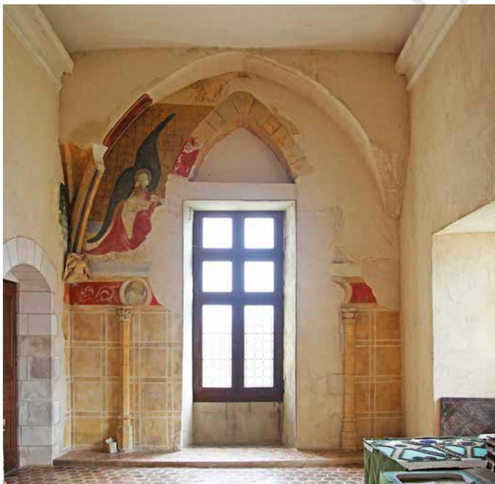
Fig. 19 – Sagonne, château, travée orientale de la chapelle, 2016.
