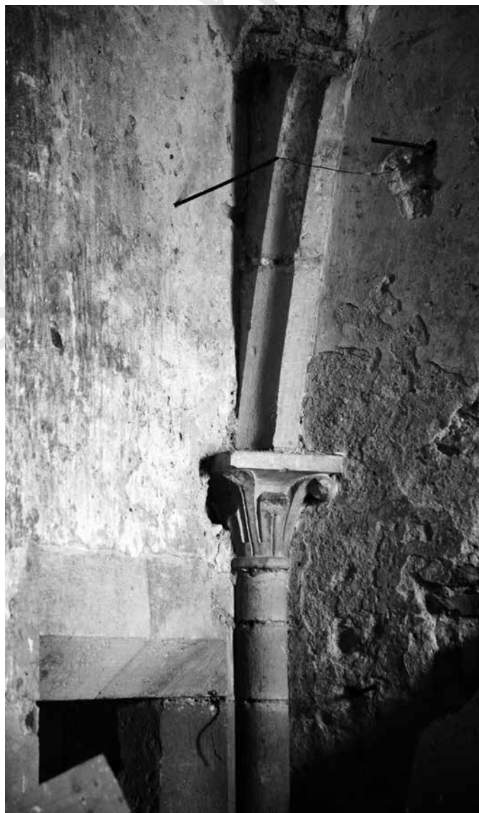
Fig. 16 – Sagonne, château, chapiteau de la salle du rez-de-chaussée de la tour résidence, dans l'angle nord de celle-ci, et porte menant à la tour nord, 2016.
